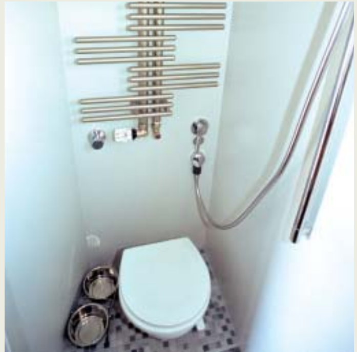
Toll: Gefließtes WC mit Handtuchtrockner aus Edelstahl.
